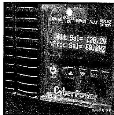
Prueba de baterías
